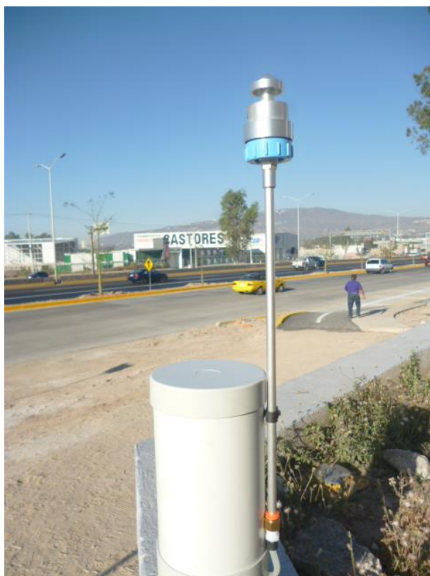
EQUIPO DE MONITOEEO DE PARTÍCULAS PM 10 EN OBRA 3
