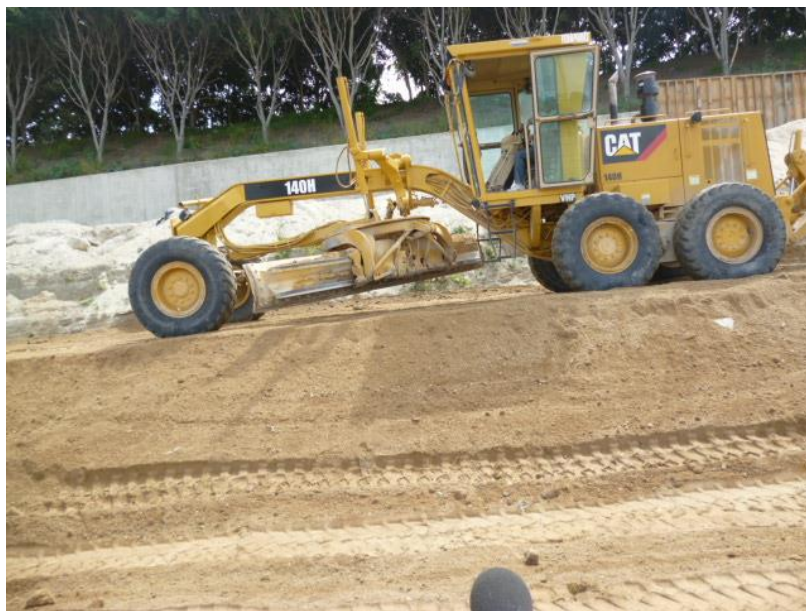
MEDICIÓN DE NIVELES DE PRESION SONORA EN OBRA 2
