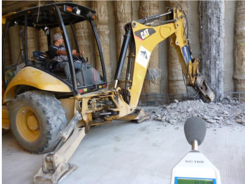
MEDICIÓN DE NIVELES DE PRESION SONORA EN OBRA 1
