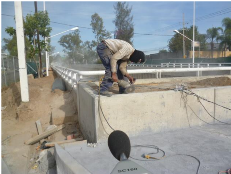
MEDICIÓN DE NIVELES DE PRESIÓN SONORA EN OBRA 1
