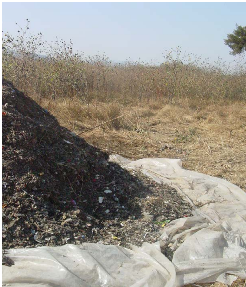
Figura 4. Pila de RSU donde se observa la membrana de polietileno que impide el contacto directo de los desechos con el suelo.
